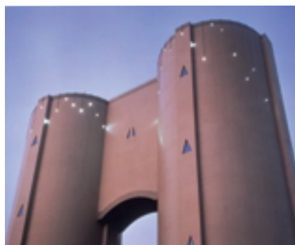
星が丘団地 給水塔 Photo：旭硝子株式会社
